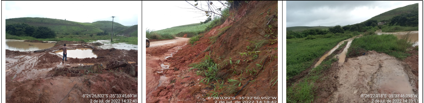
Estradas Vicinais inaptas ao tráfego por qualquer meio de transporte. Ocorrência de deslizamentos de Talude
