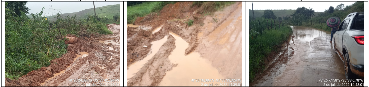
Estradas Vicinais inaptas ao tráfego por qualquer meio de transporte. Ocorrência de deslizamentos de Talude. Localidades Ilhadas
