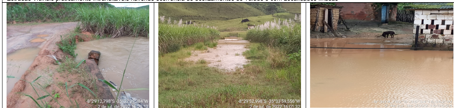
Estradas Vicinais praticamente intransitáveis havendo ocorrência de deslizamentos de Talude e com Localidades Ilhadas
