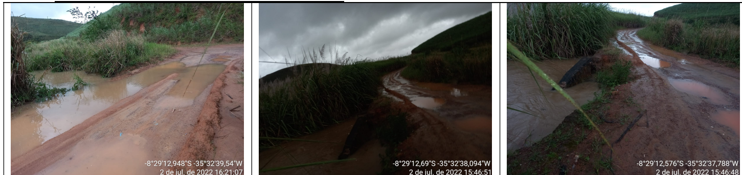
Estradas Vicinais praticamente intransitáveis havendo ocorrência de deslizamentos de Talude
